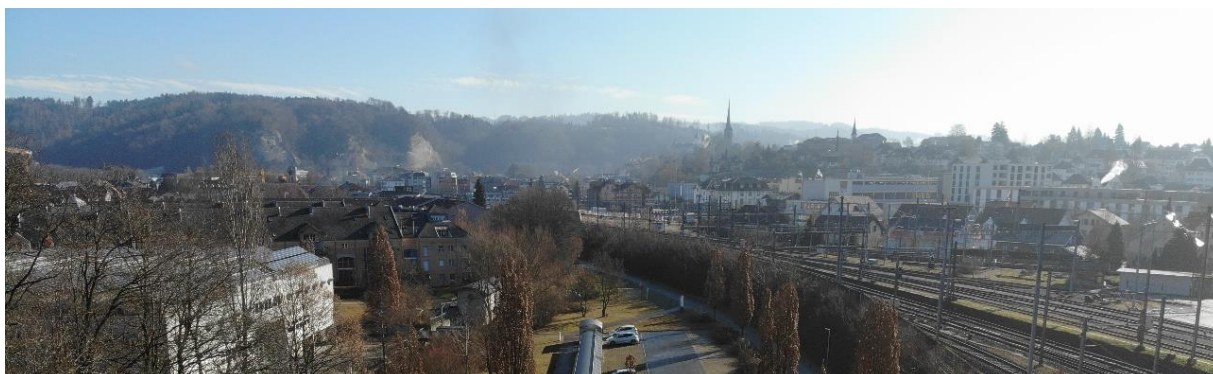
Prise de vue par drone 20 m au-dessus du périmètre de construction
